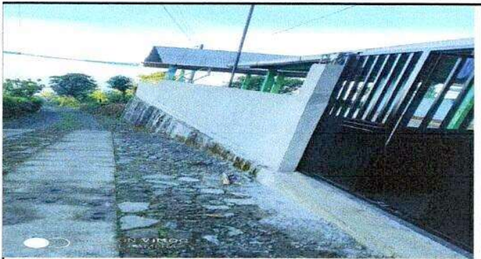
Foto 3: Reparación de muro perimetral de blok
