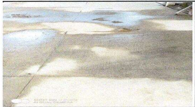
Foto 2: Sustitución de piso de torta de concreto
