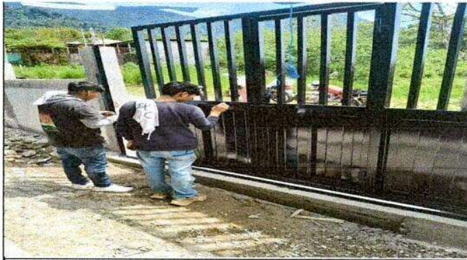
Foto 1: Sustitución de portón de metal
